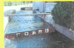
歴史ある定比式の円筒分水工(群馬県水士里ネット長野堰)
