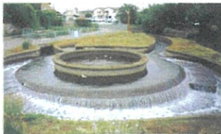
歴史ある定比式の円筒分水工(群馬県水士里ネット長野堰)
