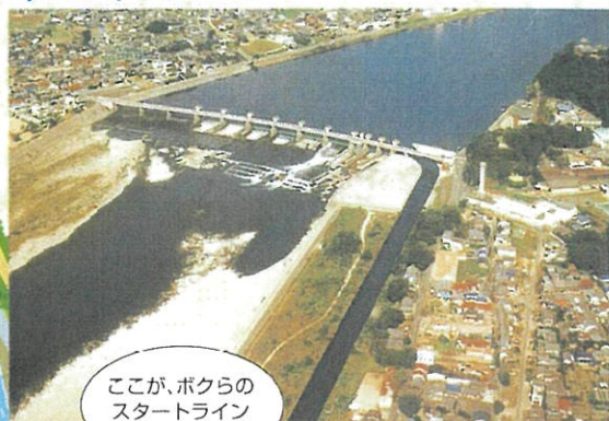
大山頭首工(愛知県・岐阜県)
