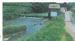
川をせき止め、水位を上げて水を取り入れる(菊川頭首工/静岡県水士里ネット大井川右岸)
