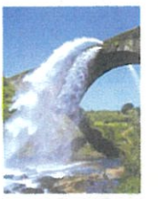
圧力差を利用し、河川を横断する水路橋の通溝橋(熊本県山都町) ※土砂吐き用の放水孔から放水しているところ
