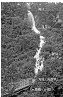
写真2 大河原堰 乙女滝と掛樋
