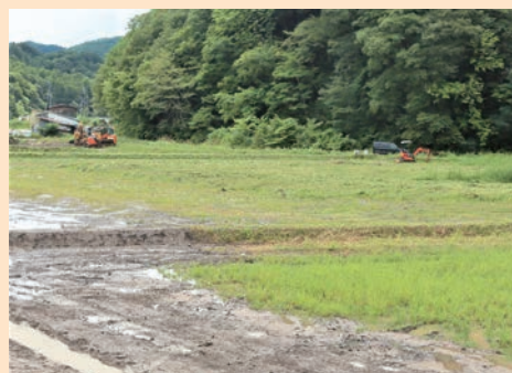
整備中の6工区
