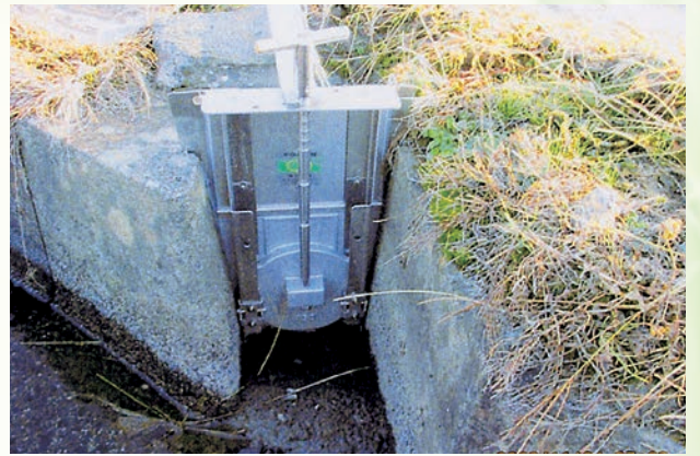
改修された水門ゲート
