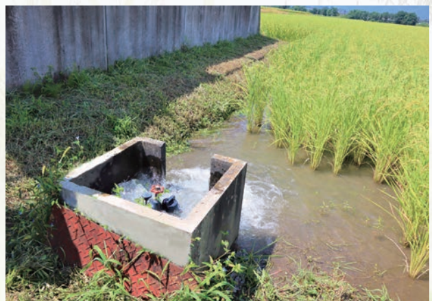
ほ場整備事業で設置された給水栓
