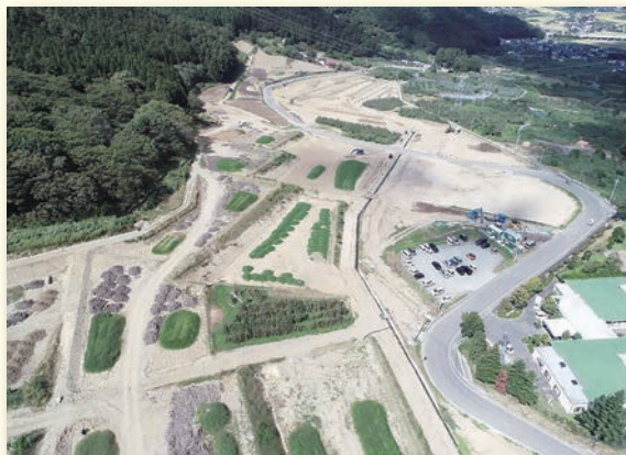
面工事が終了する山新田工区
