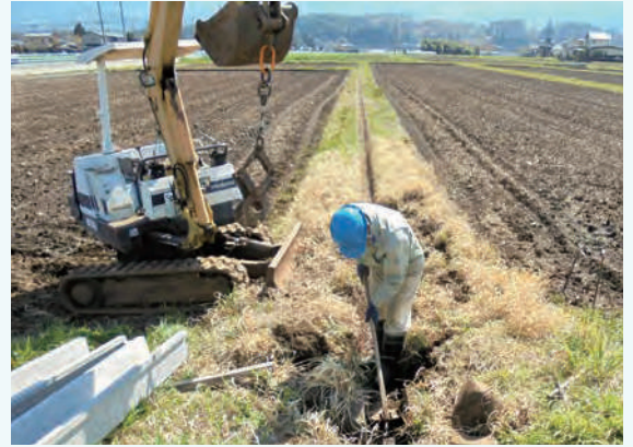
直営施工による水路布設
