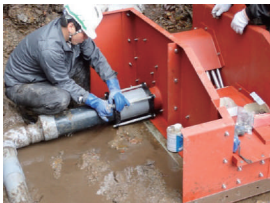
本線への導水管を接続
