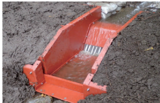
セグメント設置状況
