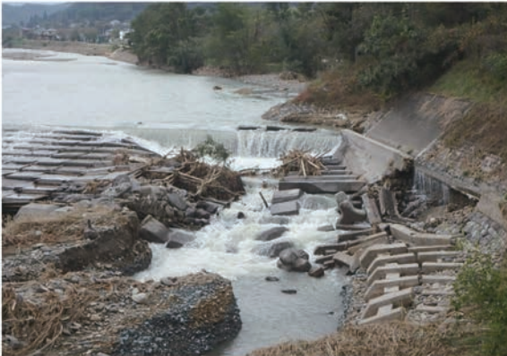
頭首工（上田市）
