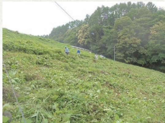
みどり湖堤体の草刈り作業
