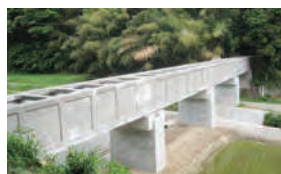
胡麻目沢水路橋
