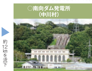
昭和4年に完成し最大出力2万6,700KWの水力発電所
