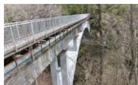
毛賀沢水路橋
