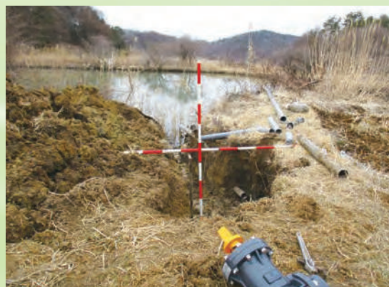
ため池へ張り巡らされている管水路修理の様子
