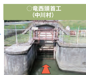
中電放水路から頭首工取水ゲートへこれより飯田市川路まで全長24kmを流下している。
