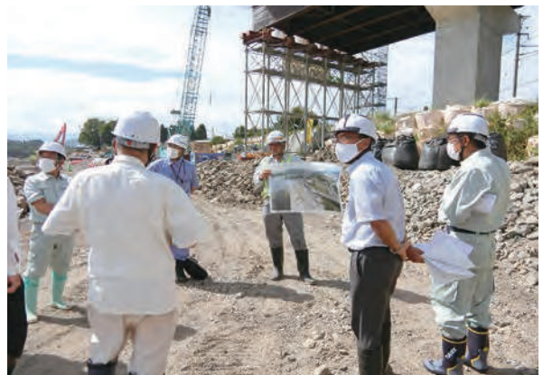
「台風19号豪雨災害復旧事業 川原田1地区」 現地視察の様子
