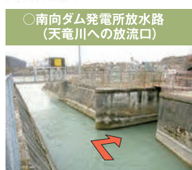
発電所の発電を終え、天竜川へ放流する為の中電放水路より一貫水路へ取水（放水から赤矢印の方向に取水）
