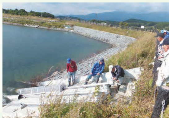
みまき大池送水口点検の様子
