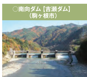
昭和4年に完成した中部電力の発電用ダム 堤高7.57m 堤頂長123.51m
