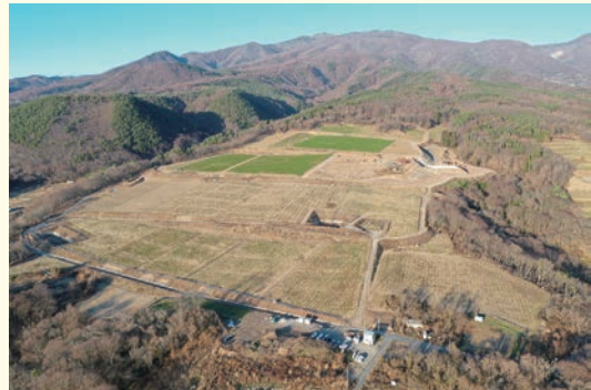
東御市祢津御堂ぶどう団地整備
