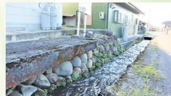
ウォーキングコースに設定された若宮堰には現在も石積みの水路が残る
