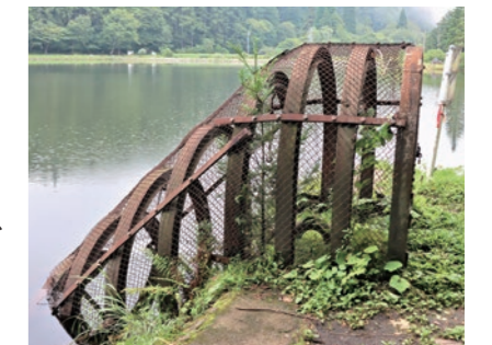
沼の池の樋門
