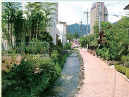
景観に配慮した市街地を流下する用水路
