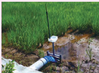
【自動給水栓 試験状況】
